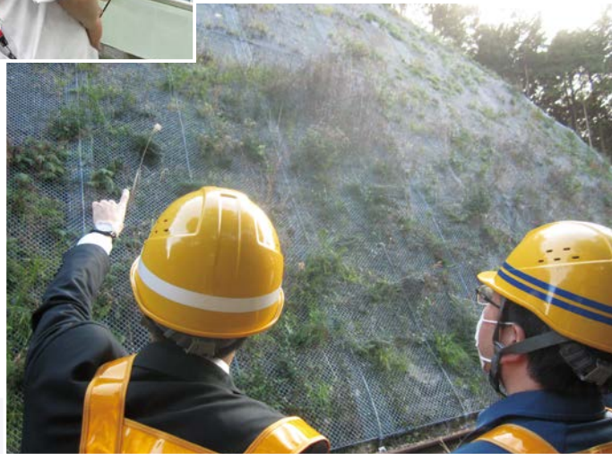
(落石対策工事)
