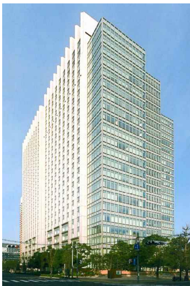
神保町仮庁舎全景
