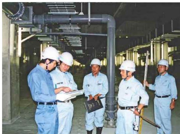
実地検査風景
