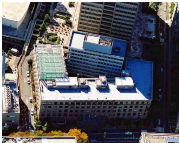
旧庁舎全体（航空写真）
