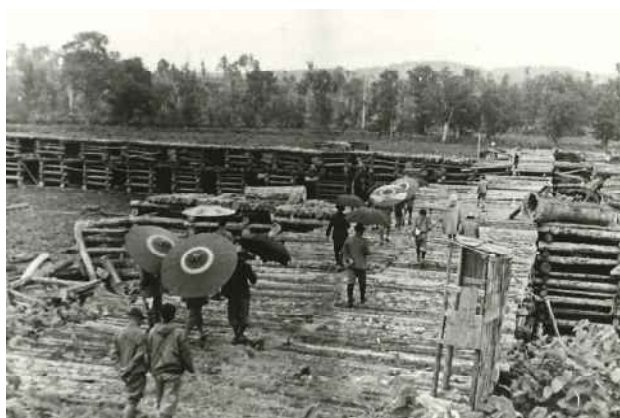
木材工場の実地検査
