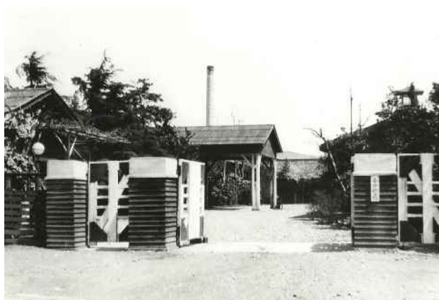
震災後の庁舎
