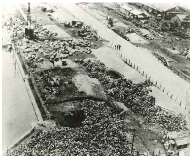
復興事業の幹線第八号路線工事（東京市麹町区永楽町濠端）
