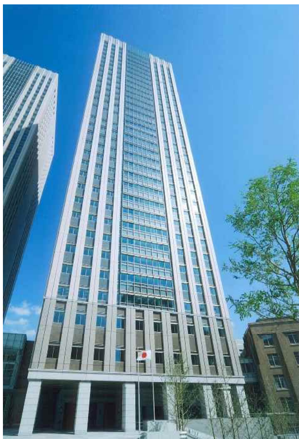
庁舎（中央合同庁舎第7号館官庁棟）
