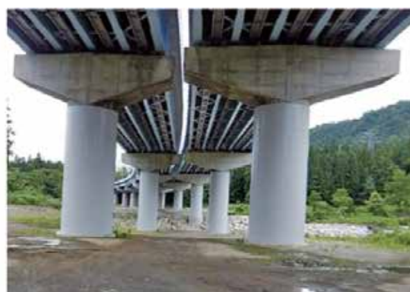
橋脚補強後(上下線2橋を同時に補強)
